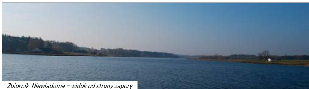
Zbiornik Niewiadoma – widok od strony zapory
