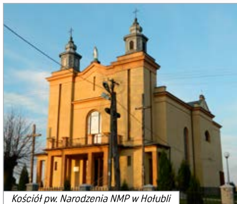
Kościół pw. Narodzenia NMP w Hołubli
