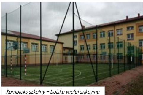
Kompleks szkolny – boisko wielofunkcyjne
