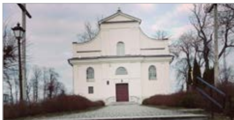
Kościół parafialny pw. Świętej Trójcy w Dziadkowicach
