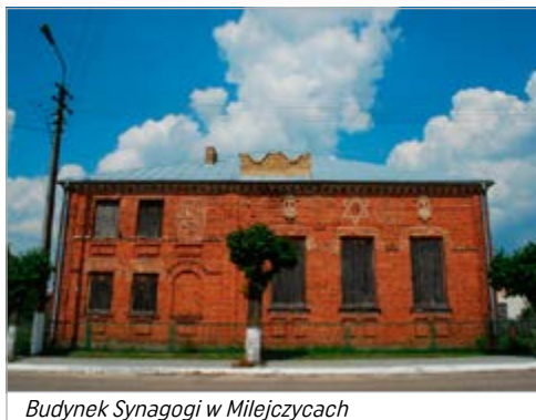
Budynek Synagogi w Milejczycach
